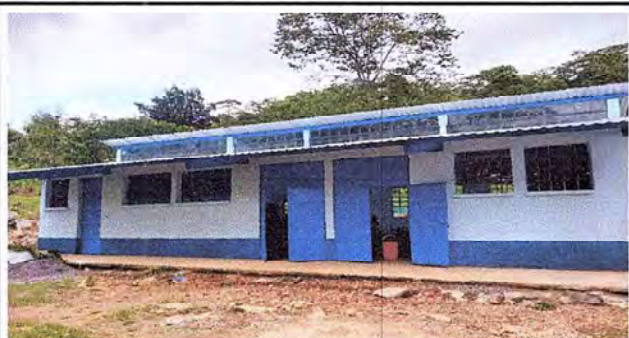
Foto 3: El mantenimiento del edificio escolar el techo, la pintura del edificio vidrios de las ventan y las puertas se logro al 100% del modulo 2
