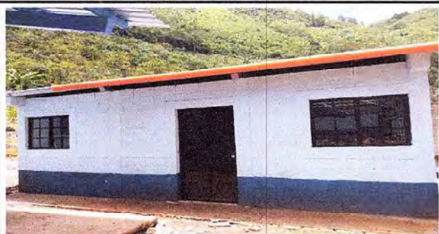
Foto1: Se logro de construir un nuevo edificio escolar de 7x6 mtc del modulo 1
