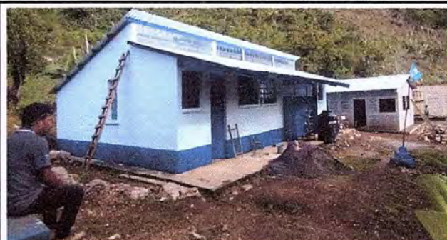
Foto 2: Mantenimiento de modulo 2
